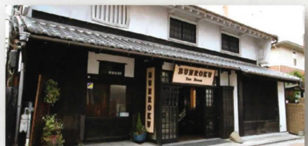
文禄堤薩摩英国館は、1926年(大正15年)に建てられた歴史ある建物です。
